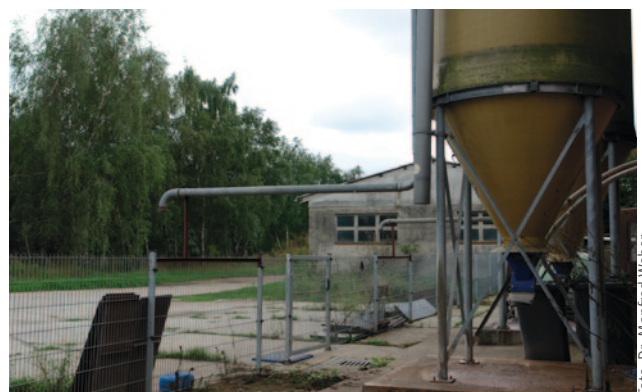
Bild 3: Langer Befüllstutzen zur Außenbefüllung
