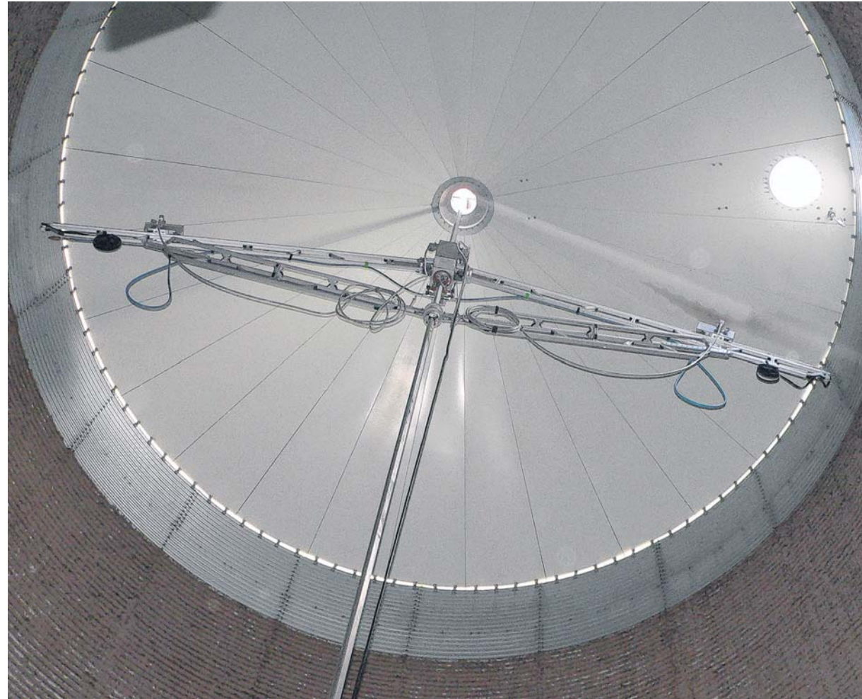
Der „Big-Silo-Cleaner“ in Aktion: Oben ist die bereits gereinigte Fläche zu erkennen, unterhalb die noch nicht gesäuberte Silowand.
